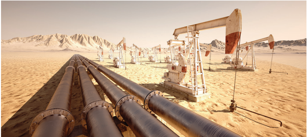
Görsel 6.9 Petrol kuyusu ve boru hattı
