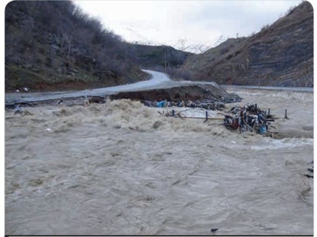
Fotoğraf 4.24 Akarsu yataklarına çöp dökülmesi bazen taşkınlara neden olabilmektedir.
