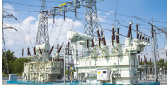
Görsel 2.33 Trafolar, alternatif akımın potansiyelini değiştirmekte kullanılır.
