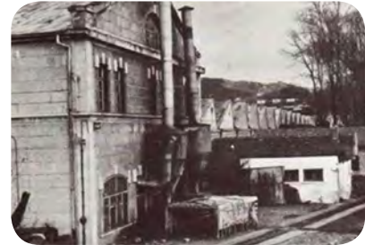
Görsel 5.7: Beykoz Deri Fabrikası
