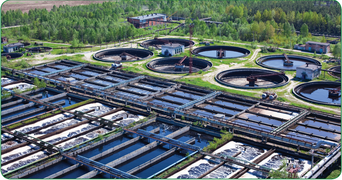
Görsel 3.97: Su Arıtma Tesisi
